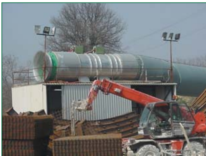
I ventilatori vengono accoppiati in serie, con potenze variabili a seconda delle esigenze di progetto.
