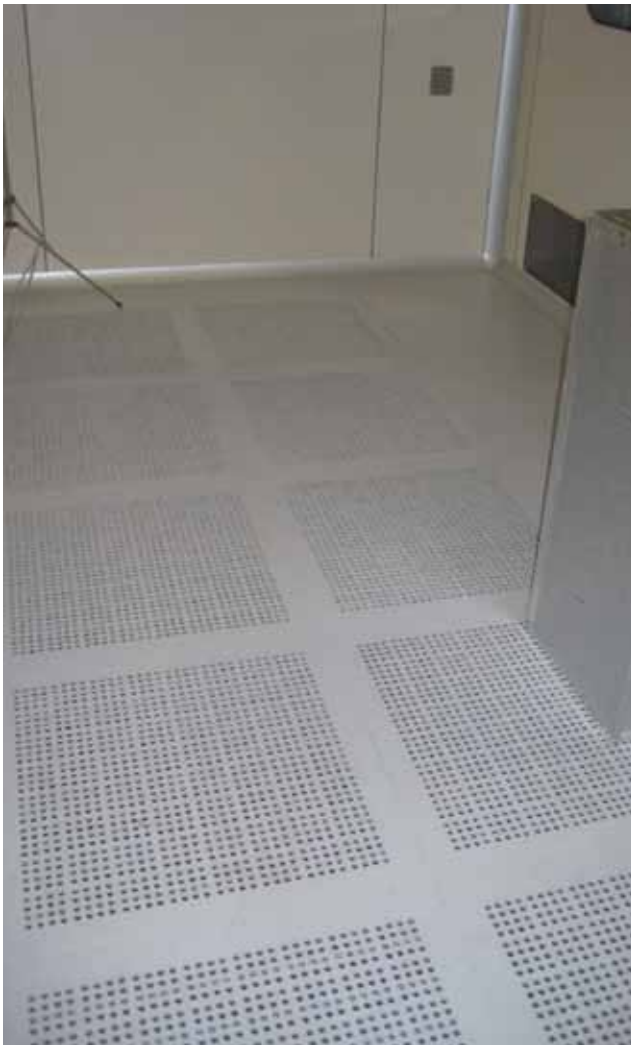
La modularità di soffitto, pareti e pavimento della camera bianca permette di configurare il sistema di immissione e di estrazione dell'aria in funzione delle prove da eseguire.
