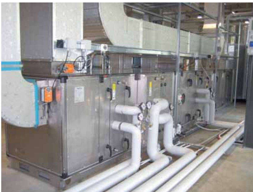
I canali dell'aria sono realizzati con pannelli preisolati antimicrobici.
