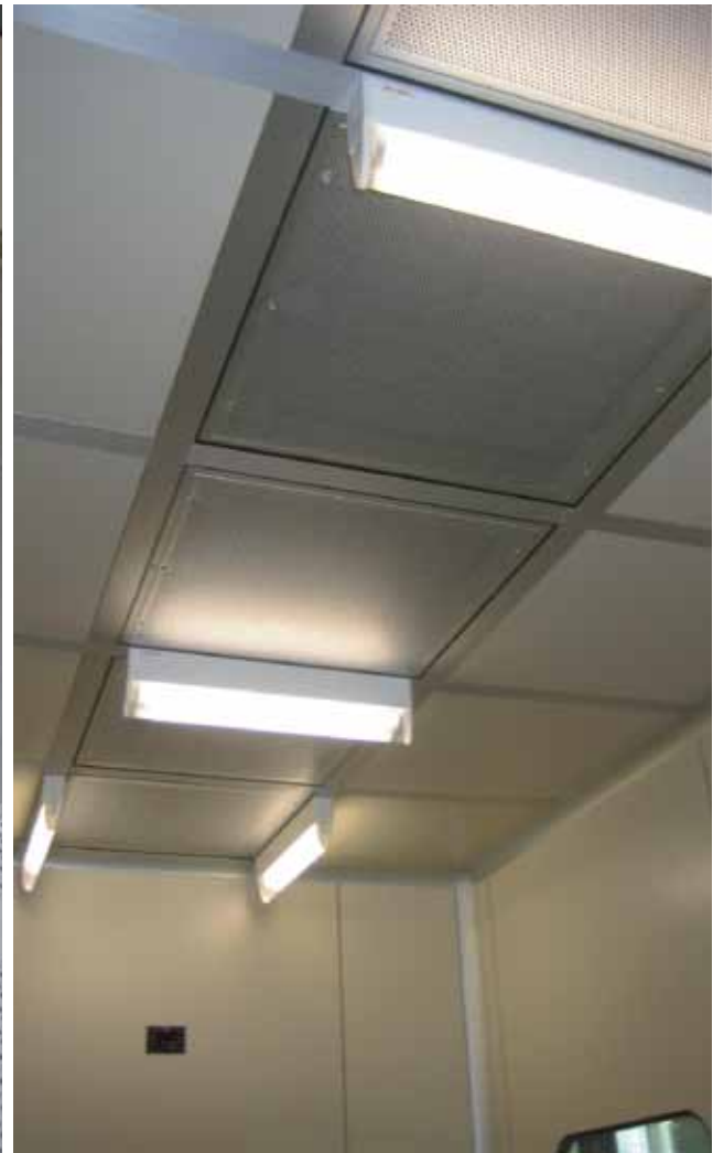
La modularità di soffitto, pareti e pavimento della camera bianca permette di configurare il sistema di immissione e di estrazione dell'aria in funzione delle prove da eseguire.
