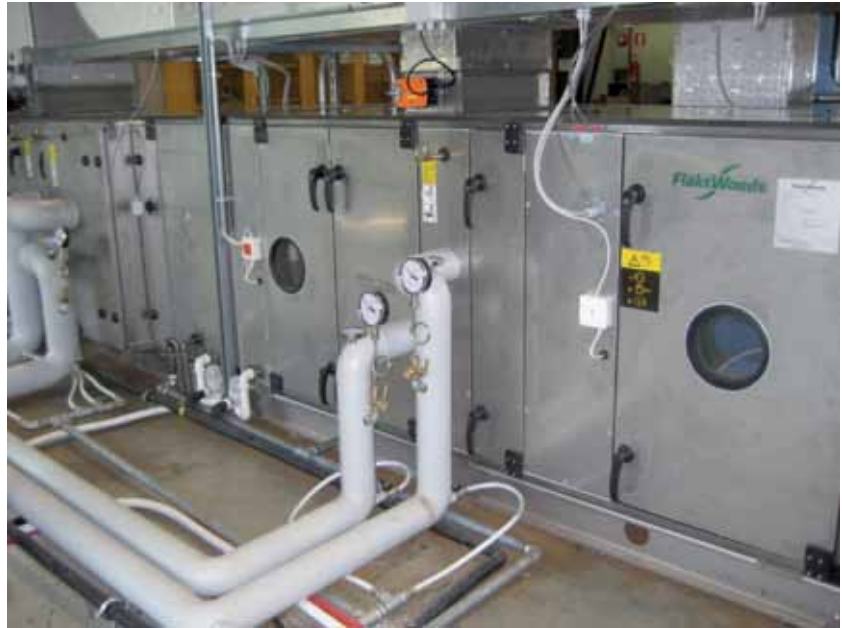
L'unità di trattamento da 3700 m 3 /h realizzata da Fläkt Woods con materiali idonei all'utilizzo in ambienti a contaminazione controllata.
