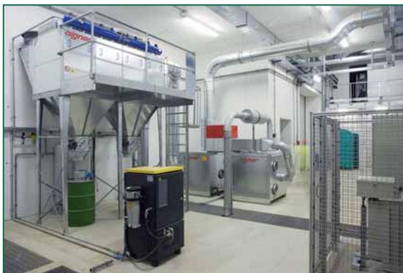
La polvere viene separata con un processo automatico e raccolta in appositi bidoni.
