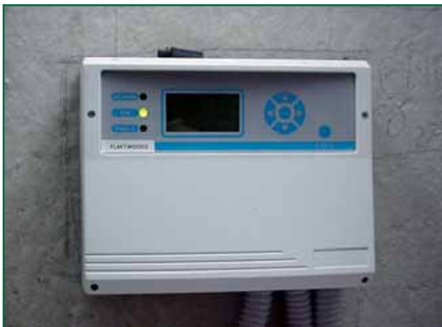
Centralina a microprocessore City 8 per il controllo fino a otto sensori.
