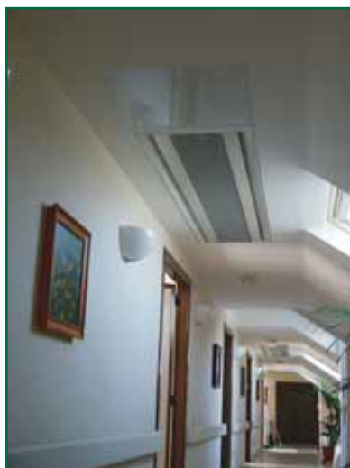
Trave integrata nel soffitto in cartongesso, dove sono stati realizzati sportelli per l'ispezione.
