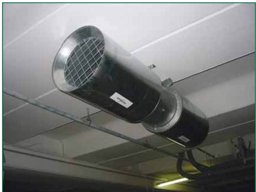
Fig. 3 - I ventilatori jetcfans sono dotati di bocchaglio sull'aspirazione e di rete di protezione sia sul bocchaglio che sulla mandata.
