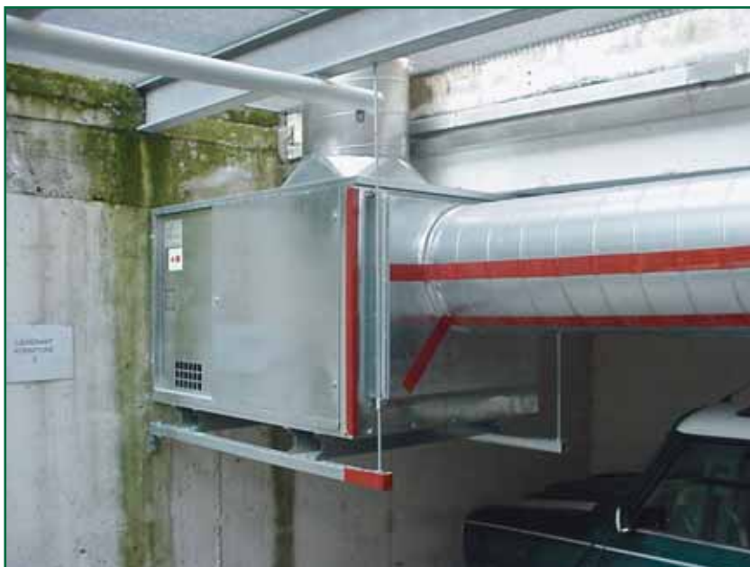
Un cassonetto della serie KDTR con aspirazione orizzontale e mandata verticale
