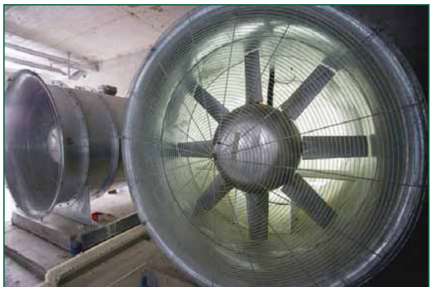
I ventilatori assiali totalmente reversibili serie Aerofoil JM
