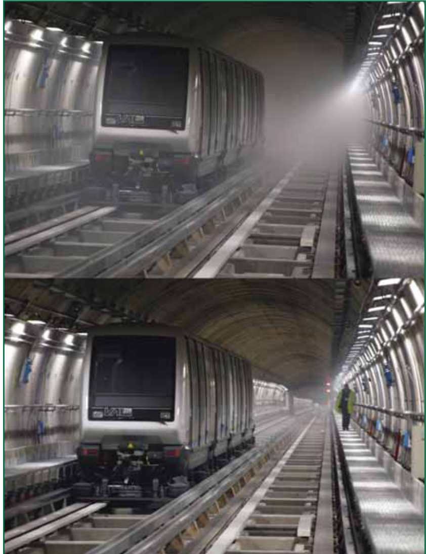
Alcuni momenti delle prove di emergenza incendio: la situazione fumi in galleria prima (sopra) e dopo (sotto) la partenza del sistema di ventilazione in estrazione
